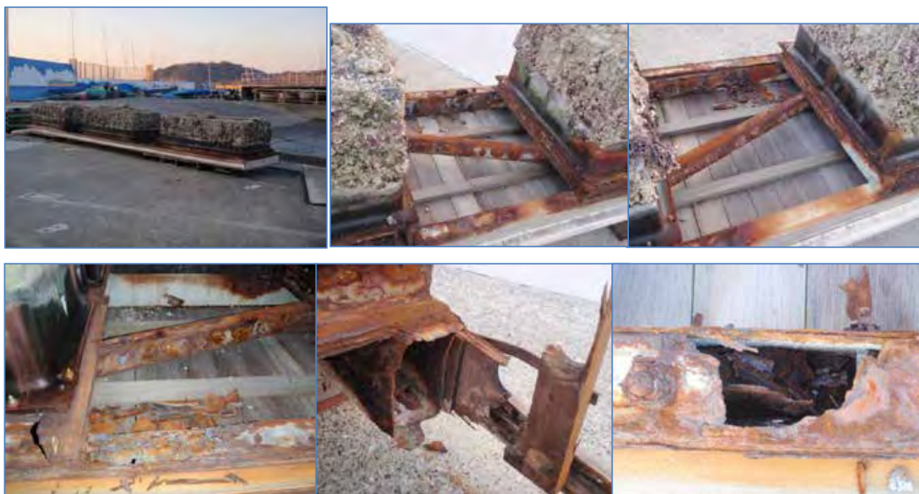
鋼製角パイプ破断面
