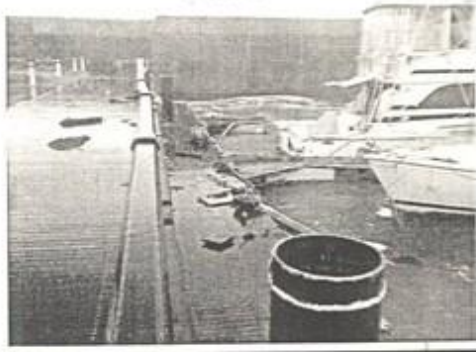
①新港第1浮棧橋
