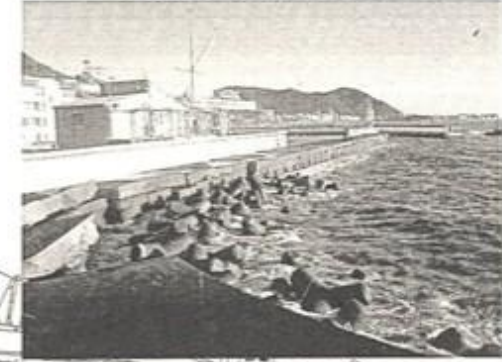
⑤防災泊地消波工
